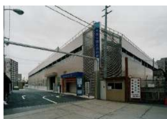
長居公園北西駐車場
