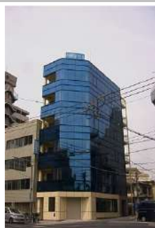
寺田町第二ビル
