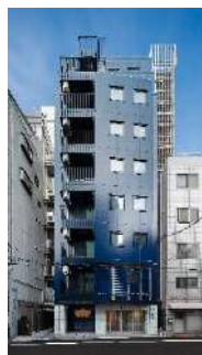
HOTEL S-PRESSO West
