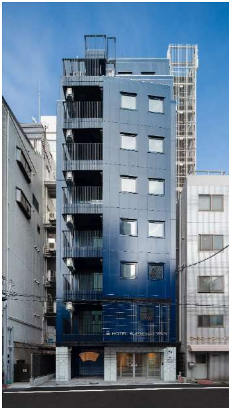
HOTEL S-PRESSO West
