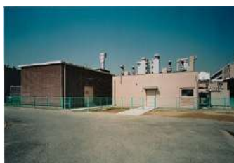
近畿中央呼吸器センターRI 棟
