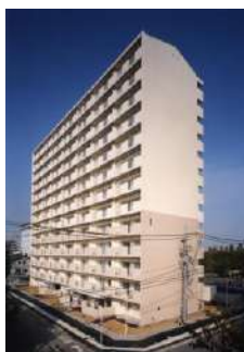
大阪府営公園南住宅
